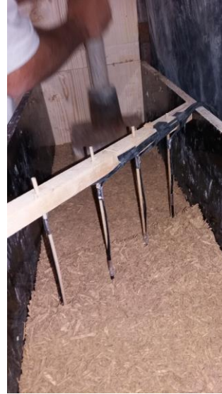
Instrumentation dans la paroi
