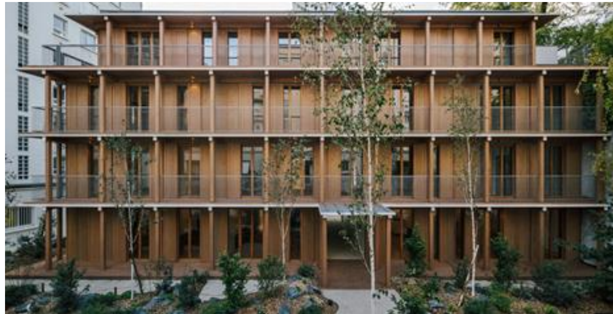
Construction Bois (Habitation fabriquée en LCAs à Paris)
