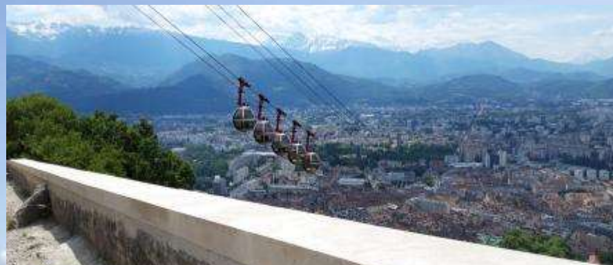
La Bastille de Grenoble, Isère (France) Restauration du mur de soutènement se trouvant à proximité de l'arrivée du téléphérique.
