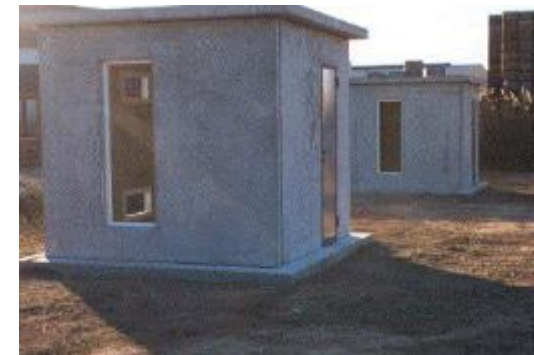
Enceinte incorporant des MCPs (Cabeza et al. 2007)
