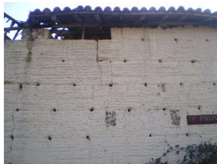
Ruine en pisé: absence d'élément grossier dans la terre
