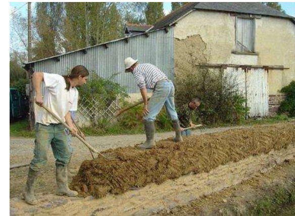
Bauge : terre plastique empilée (avec des fibres végétales ou pas)
